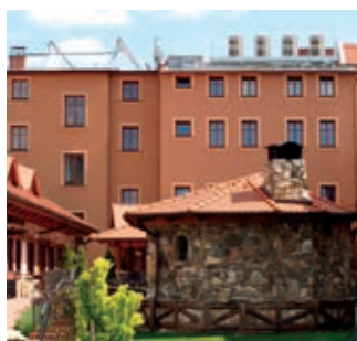
Hotel Katharein. Kaskádové systémy tepelných čerpadel Panasonic. Opava, Česká republika. Aquarea
