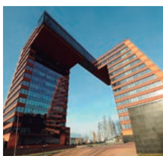
Technopark Novosibirsk, Academgorodok. Novosibirsk, Rusko. ECOi
