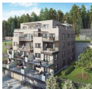
Nový bytový dům. Komplex Bergås Terrasse. Drammen, Norsko. ECOi / Aquarea
