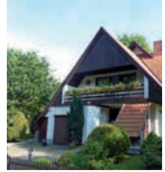
Rodinný dům úsporně vytápěný tepelným čerpadlem o výkonu 9 kW. Česká republika. Aquarea
