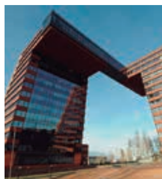
Technopark Novosibirsk, Academgorodok. Novosibirsk, Rusko. ECOi
